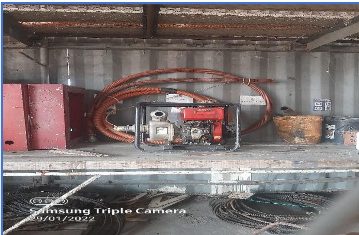
Vista fotográfica N° 3: Motobombas y mangueras
