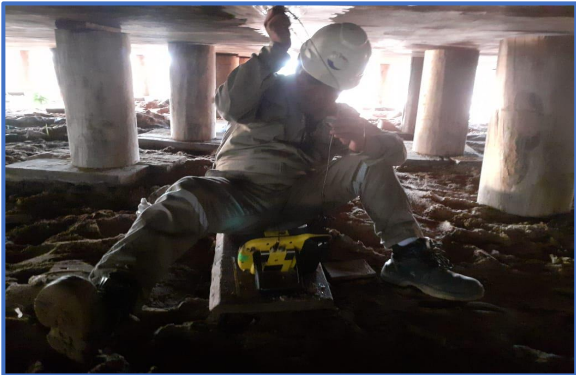
Vista fotográfica N° 13: Inspeccion de ultrasonido del AF KENIA XXI
