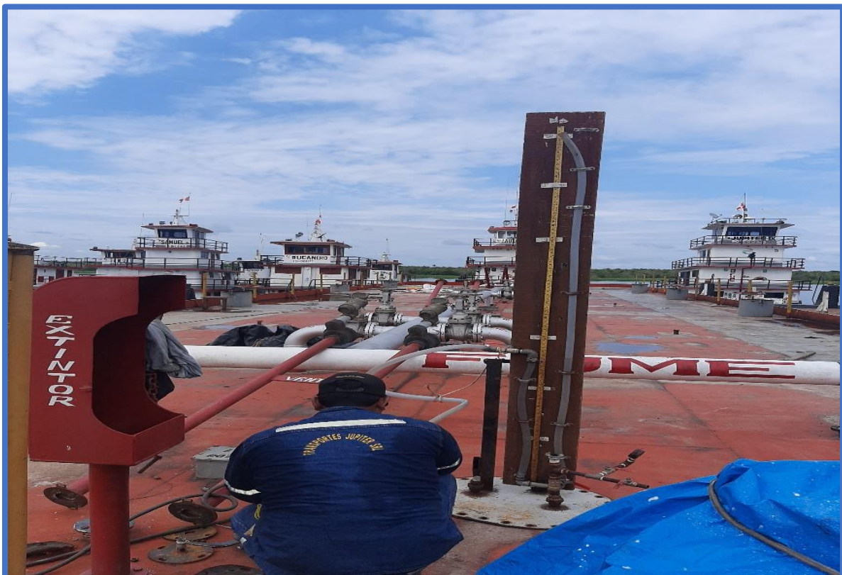
Vista fotográfica N° 22: Prueba neumática – AF KENIA XV
