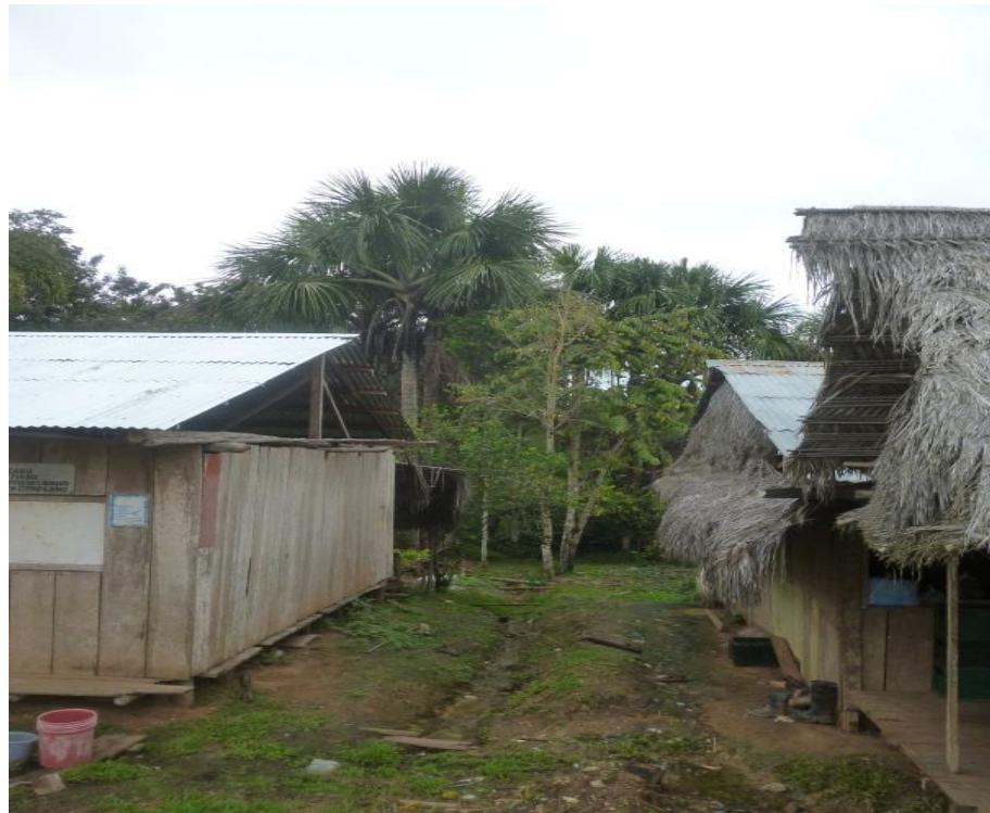
Foto 2. Sistema de drenaje de aguas en Cuyana
