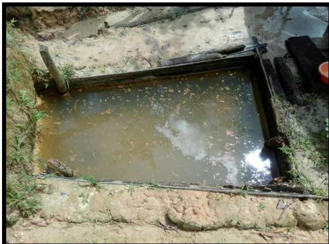
Imagen 9. Pozo ciego, agua esorrentía
