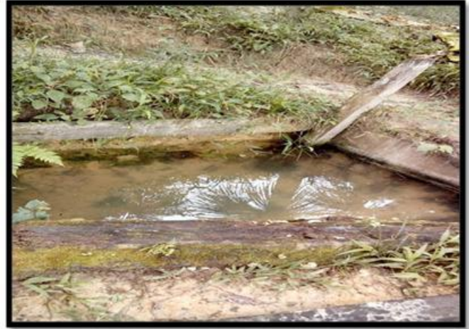
Imagen 04. Pozo por escorrentía, sin protección
