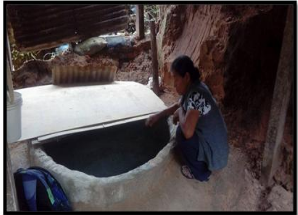
Imagen 02. Pozo revestido con concreto, tapa provisional
