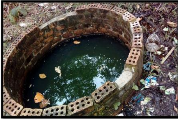
Imagen 01. Pozo con base de concreto
