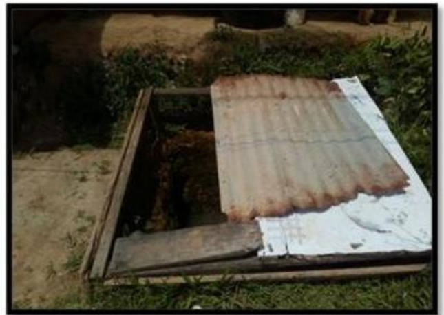
Imagen 06. Pozo ras del suelo. Calidad de pozos en el centro poblado Quistococha
